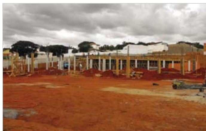
Nova unidade do Sesi em Jaboticabal. As obras já se estendem por quase todo o terreno. Em breve, uma escola com mais de 40 salas de aulas estará erguida.
