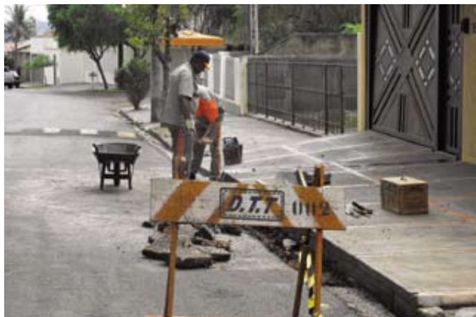
Obra em frente à residência do vereador Dr. Aloísio. Abuso de poder em andamento?
